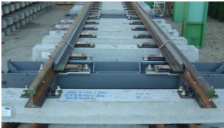
Obr. 21 Výměna na betonových pražcích
