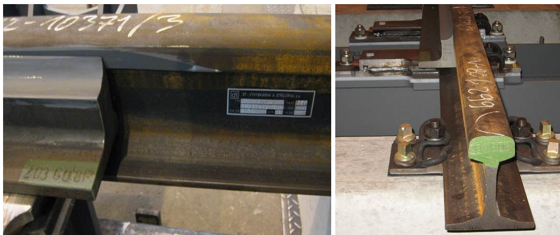
Obr. 13 Příklad identifikace výměny – pohled z boku a z čela
