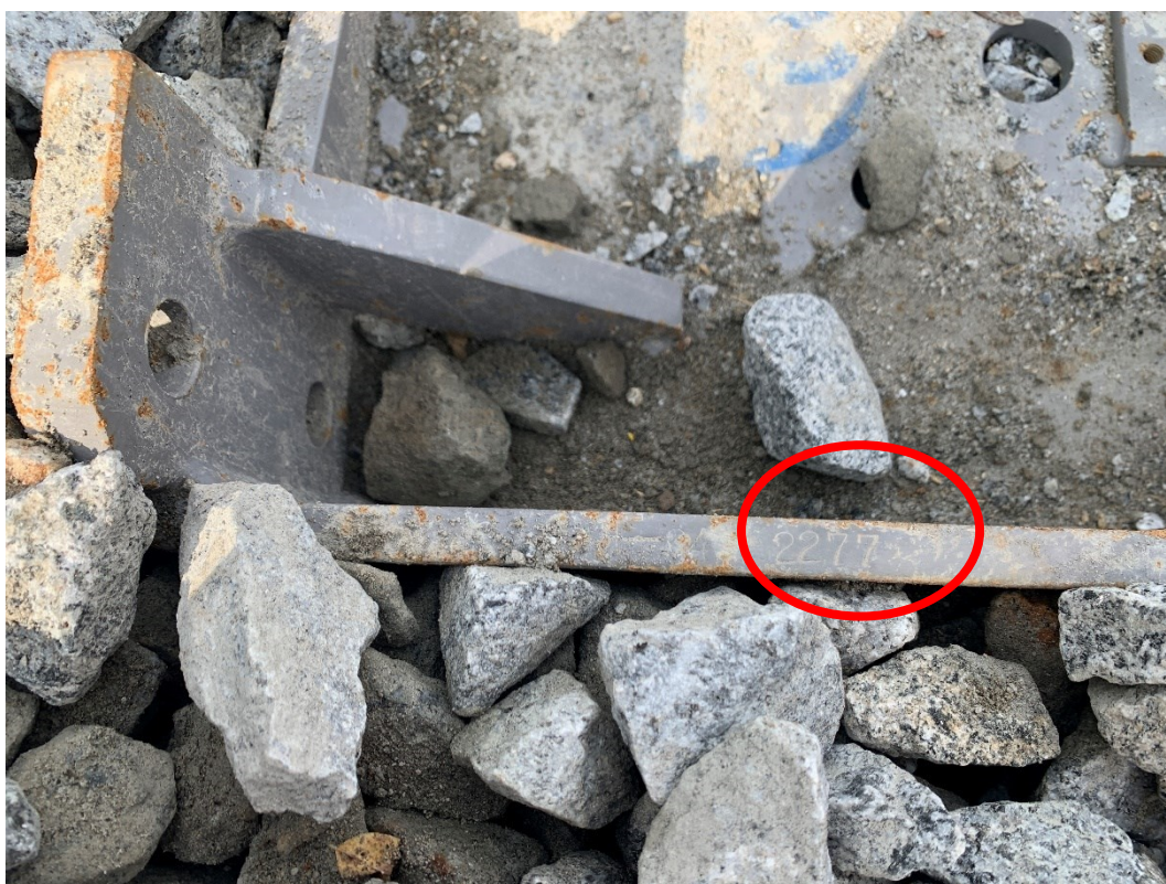
Obr. 19 Identifikace širokého žlabového pražce
