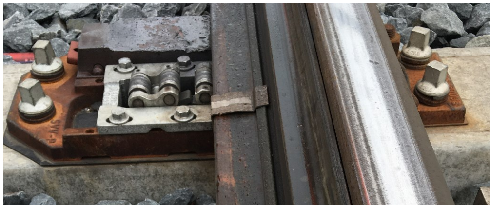
Obr. 6 Válečková integrovaná stolička – typ SVV-P
