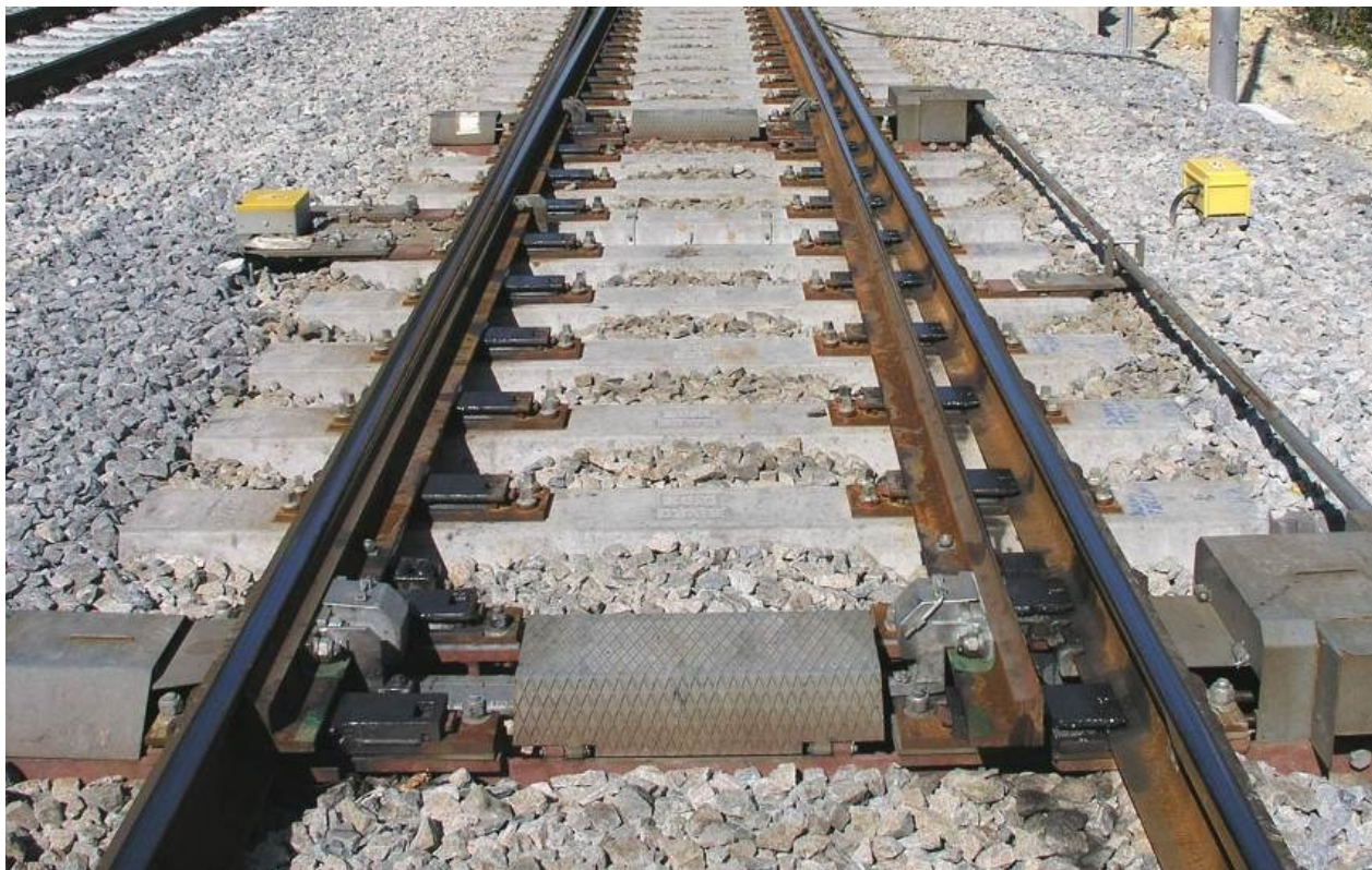
Obr. 1 Výměna jednoduché výhybky
