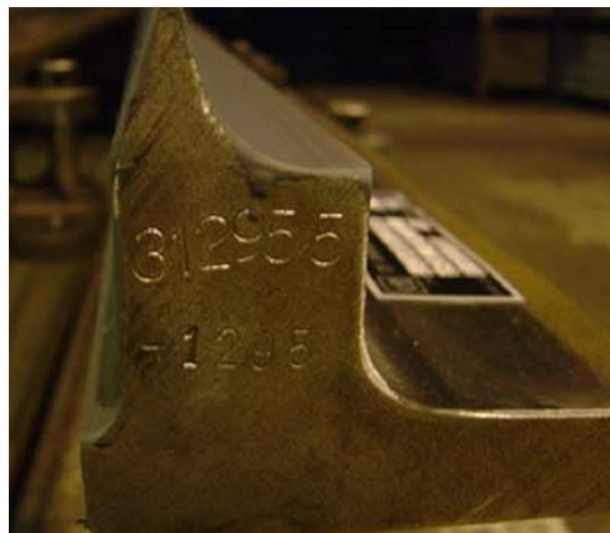
Obr. 14 Příklad identifikace jazyku-pohled z čela
