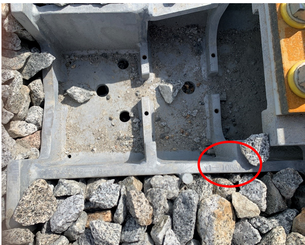
Obr. 20 Identifikace úzkého žlabového pražce
