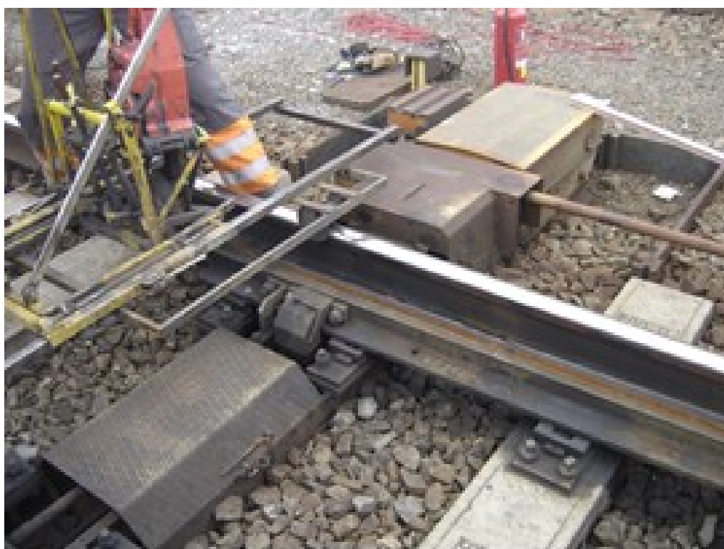
Obr. 63 Odrolený jazyk před broušením
