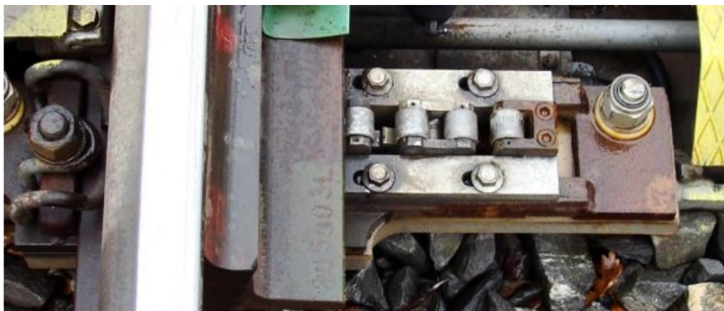
Obr. 8 Válečková stolička na 1. žlabový pražec, typ SVV-ZP
