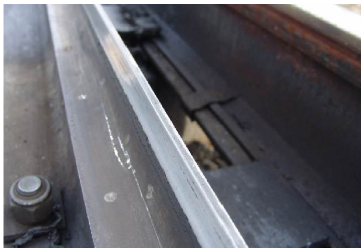
Obr. 39 Boční ojetí hrotu jazyka jízdním obrysem kola
