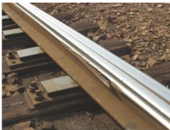
Obr. 42 Odtržený převalek při zanedání údržby
