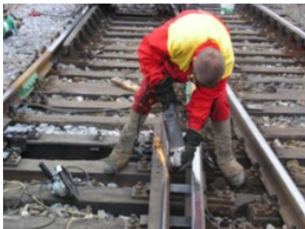
Obr. 54 Ruční broušení leštícím kotoučem
