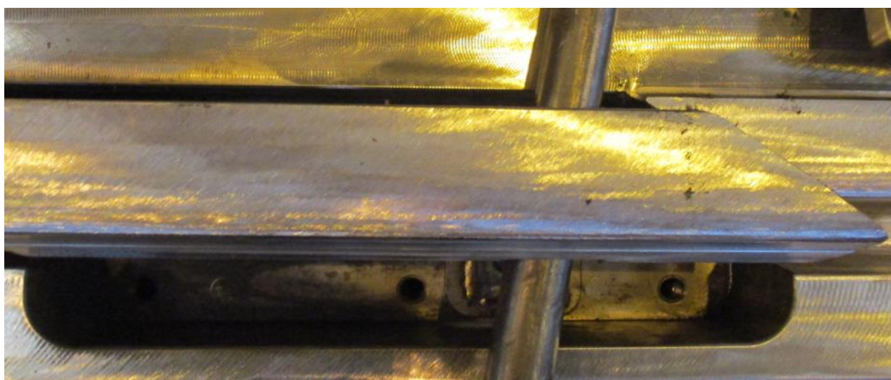
Montážní pákou podložit uvolněný konec jazyka
